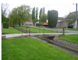
Passerelle piétonnière dans le centre-bourg
