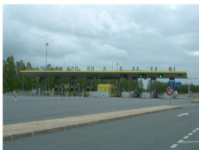
Péage à proximité de la commune
