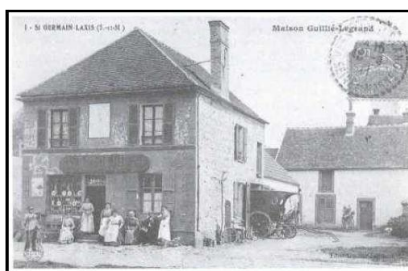
Maison le long de la RN 36
